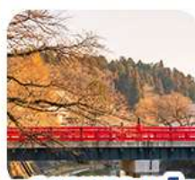
สะพานนากะบาชิ
