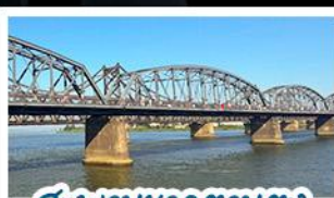
สะพานขาดตานตง
