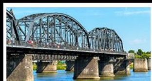
สะพานหวาดถานตง
